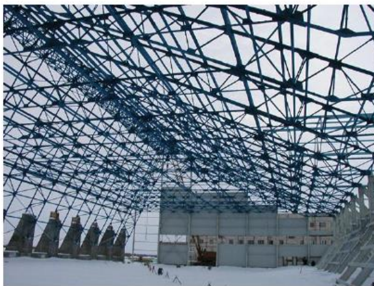
Рис. 12. Усиленный металлический каркас спортивного сооружения
