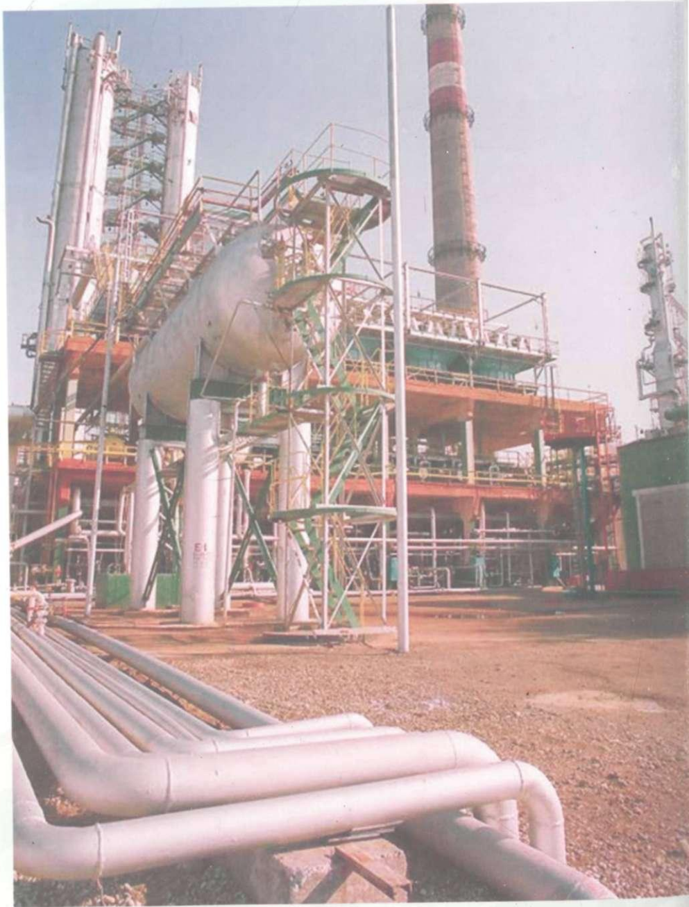
Zamonaviy texnologiya asosida rekonstruksiya qilingan Farg'ona neftni qayta ishlash zavodi.
